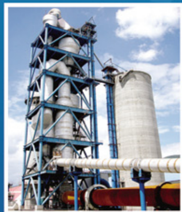
邢台中联水泥有限公司 水泥熟料产量: 1x2000t/d NO x 排放浓度: 300mg/Nm 3
