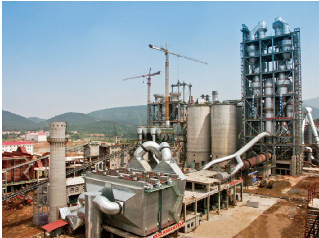
铜陵海螺水泥有限公司万吨线全景，旁边是建设中的二线，也是一条万吨线。
