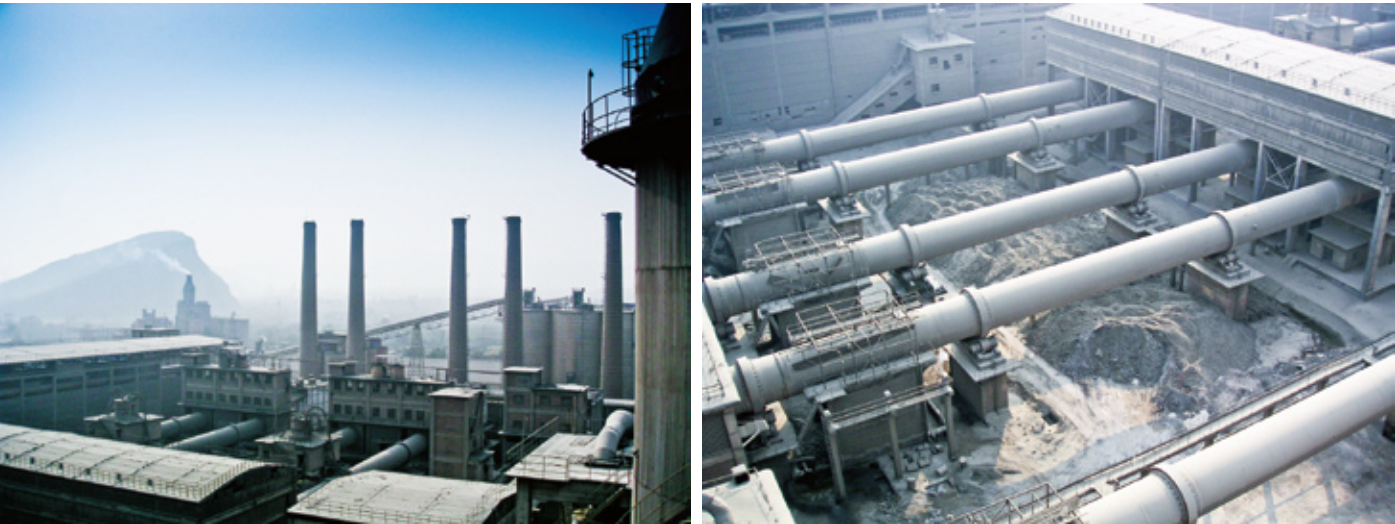
图为浙江三狮集团停产的5条湿法线，现已被拆除。2003年前后，浙江新型干法水泥生产线大批上马，集中投产，导致市场竞争异常激烈，湿法线早就没有了竞争力，不得不停产关闭。
