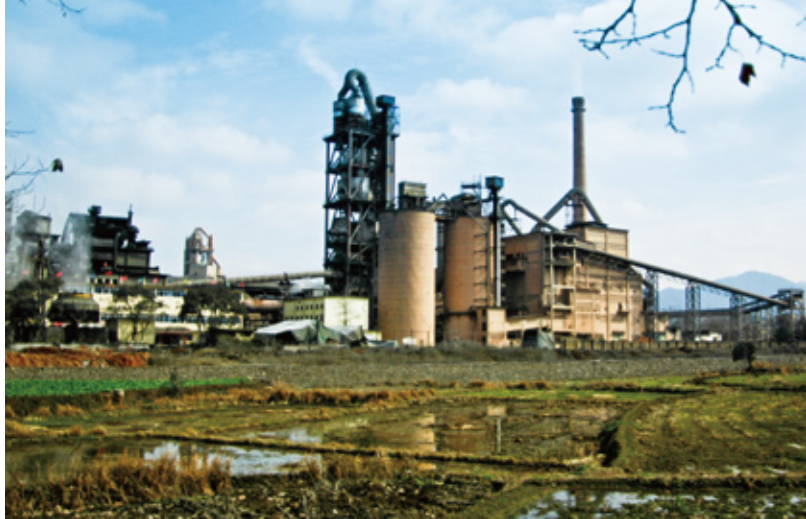
图为江西万年青水泥有限公司2000t/d新型干法水泥生产线，该生产线于1984年开工，1986年建成，调试三年才最终达产达标。这也是中国自行设计，主要用国产设备建成的第一条2000t/d新型干法水泥生产线。
