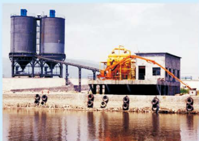
负压卸船、气力输送入库
