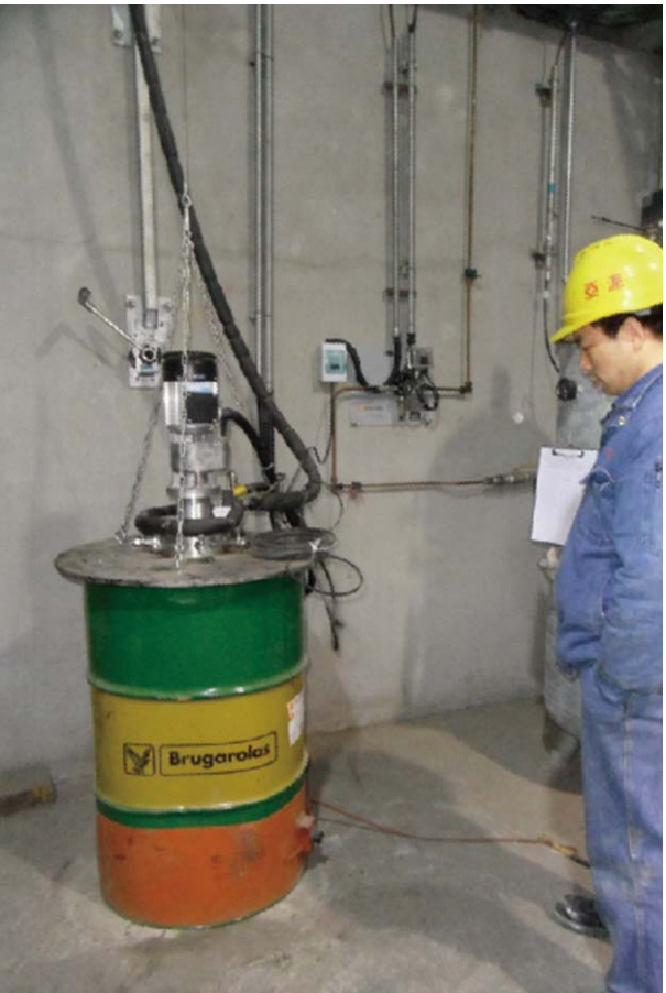
气动泵+提升装置+独立油站
