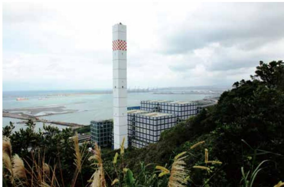
八里垃圾焚化厂主要采用机械混烧法，炉床24小时连续作业，利用焚化垃圾所产生的热量发电。
