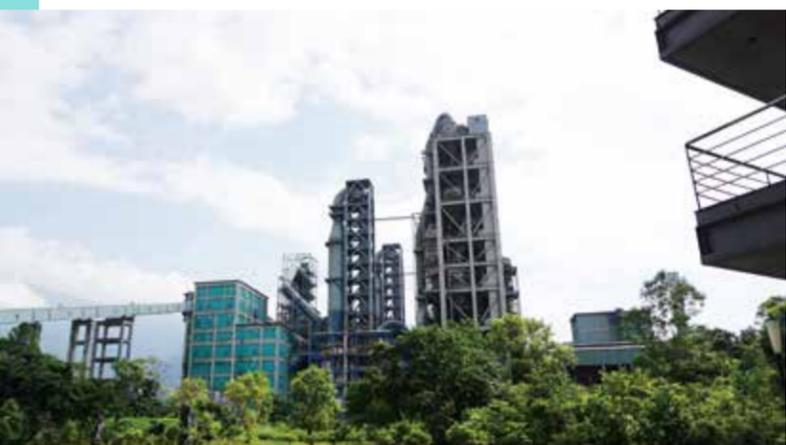
台泥和平厂处处都体现着其对环保理念的追求。和平厂背靠20亿吨石灰石矿山，拥有两条8600t/d熟料生产线，配有发电能力为31500千瓦余热发电系统。
