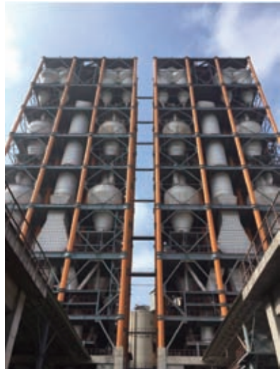
图8.带低氮燃烧脱硝六级旋风筒预热器实景
