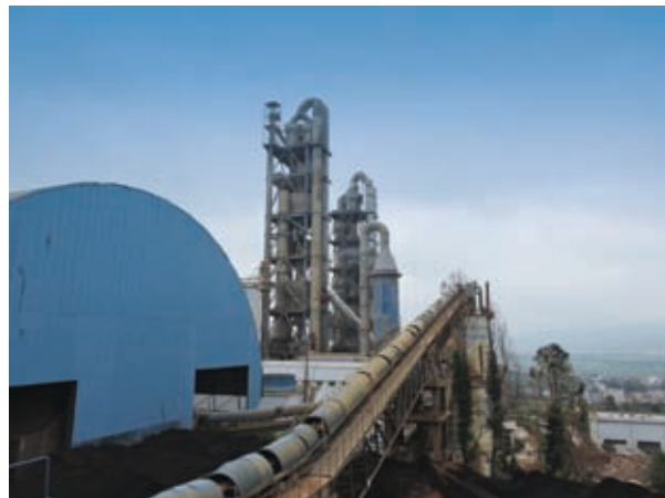
原料输送廊道，承担原料输送任务
