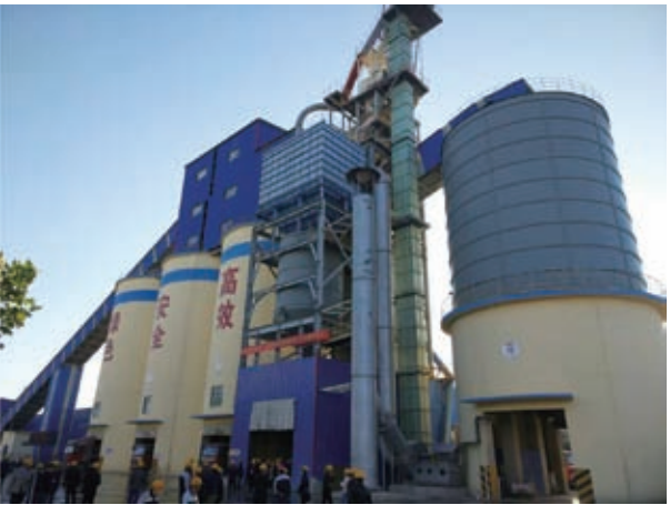
临沂中联水泥有限公司——枣庄鑫金山精品砂石骨料及机制砂示范线
