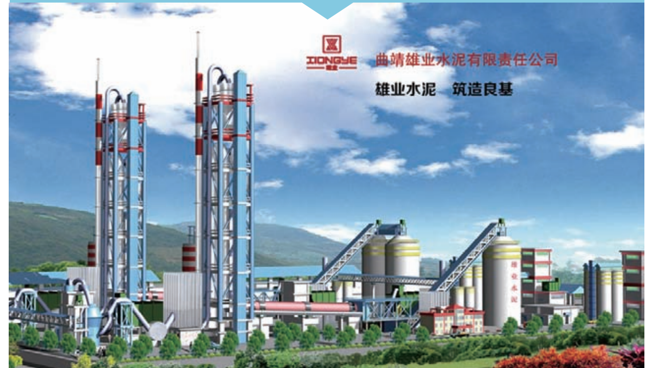
雄业水泥现代化生产线
