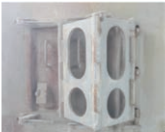
预热器人孔门（内部含凹槽，用盘根密封）
