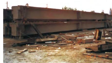
图6 用于建造北京立交桥的混凝土梁
