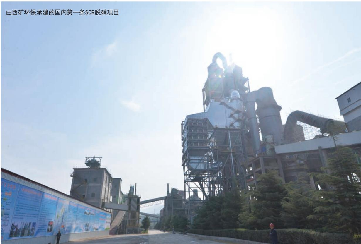
据中国水泥网消息,10月14日,河南省登封市礅槽集团宏昌水泥有限公司SCR脱硝项目通过专家组核查。该项目可实现氮氧化物排放量低于 $50\text{mg}/\text{m}^3$ ,开创中国水泥行业之先河。
