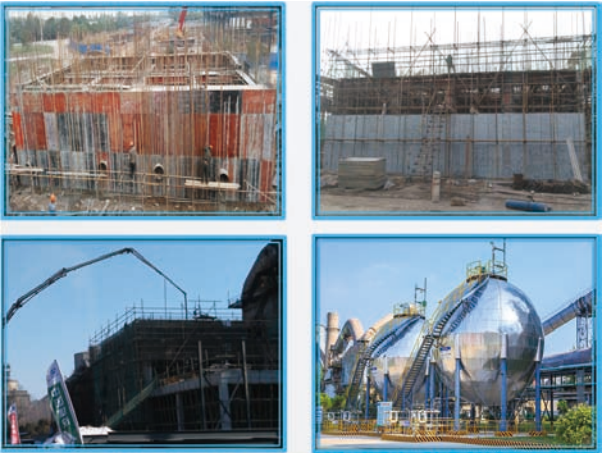
白马山水泥厂水泥窑烟气CO2捕集纯化示范项目建设过程缩影
