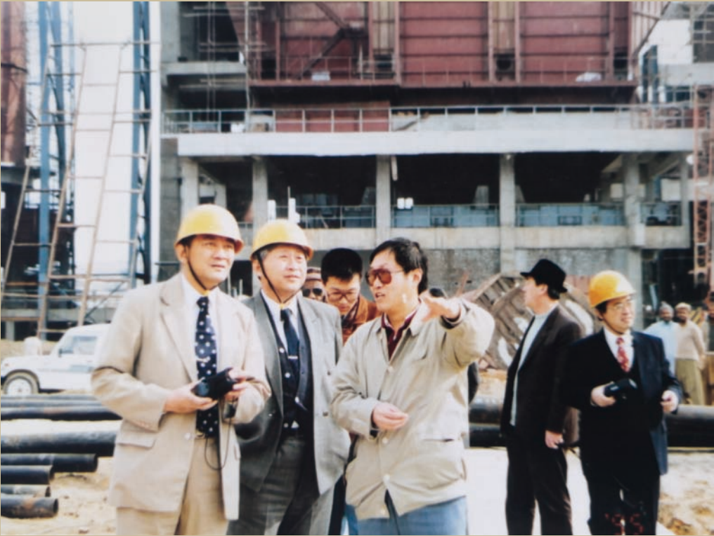
图为1995年蒋明麟（左一）在巴基斯坦（AWT）项目工程现场。
