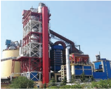
图10 河南大地水泥有限公司2#4500t/d线烟气脱硝系统 2021年与鹤壁豫鹤同力水泥有限公司4500/d生产线烟气脱硝系统,采用高温高尘SCR宽温高效催化(KGC)技术。
