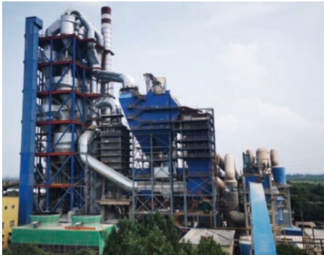
图8 焦作千业水泥有限责任公司2×5000t/d熟料窑烟气脱硝系统 2020年5月与河南孟电集团水泥有限公司签订2×5500t/d+1×4500t/d生产线窑尾烟气氮氧化物深度治
