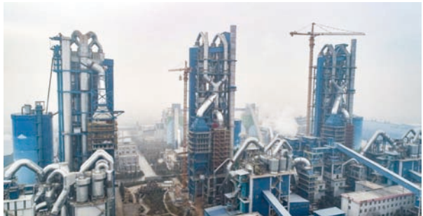
图9 河南孟电集团水泥公司2×5500t/d+1×4500t/d生产线烟气脱硝系统 2020年8月与河南省大地水泥有限公司签订2#线4500/d生产线烟气脱硝系统,采用高温高尘SCR宽温高效催化(KGC)技术。
