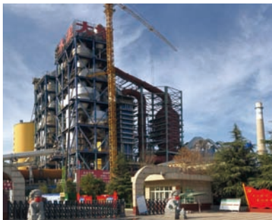
图10 河南大地水泥有限公司2#4500t/d线烟气脱硝系统 2021年与鹤壁豫鹤同力水泥有限公司4500/d生产线烟气脱硝系统,采用高温高尘SCR宽温高效催化(KGC)技术。
